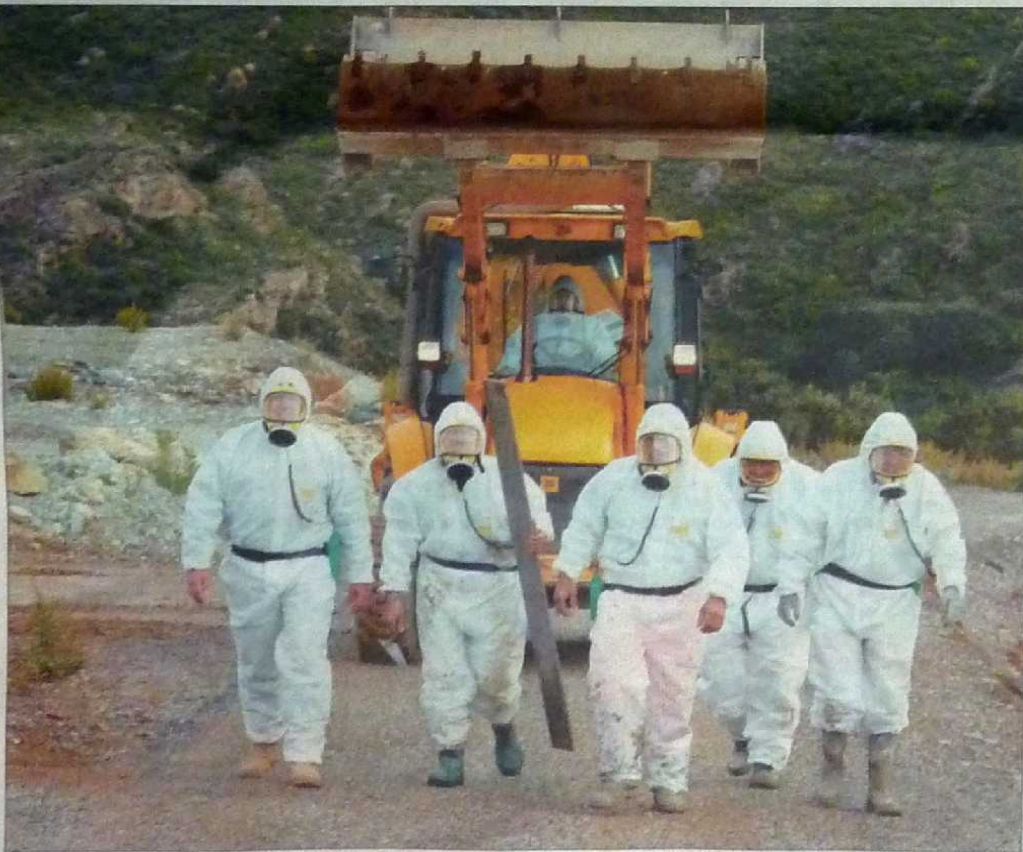
Vêtus d'une combinaison étanche et d'un masque pouvant supporter 4 000 fibres d'amiante par heure dans l'air les employés de Vinci retravaillent sur le chantier depuis le mois de février après une longue interruption.
