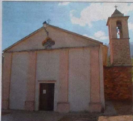
L'église Saint-Panrace à Barghjiana a été entièrement construite par les bergers et les habitants.
